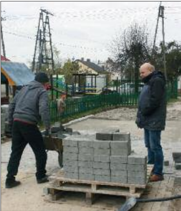
Dyrektor Andrzej Kraszewski osobiście dogląda budowę
