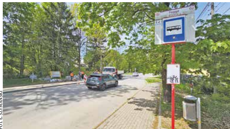
Budowa przystanku Fogga już się rozpoczęła. Nowy peron będzie miał 20 m długości i zostanie przystosowany do obsługi autobusów wszystkich typów
